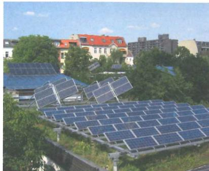
Die Solarflächen auf den Dächern betragen ca. 700m<sup>2</sup> und produzieren um die 65.000kWh Strom pro Jahr, genug für knapp 20 Familienhaushalte. Systeme, die sich nach dem Stand der Sonne ausrichten, werden erprobt. Einsparpotenzial: 40t CO<sub>2</sub> pro Jahr.
