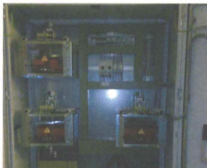
Diese Anlage regelt die Stromversorgung aller Gebäude. So bleibt die Netzspannung konstant, im optimalen, die Verbraucher schonenden und kostengünstigen Bereich. Einsparpotential: knapp 20t CO<sub>2</sub> pro Jahr und ca. 12% der gesamten Stromkosten.
