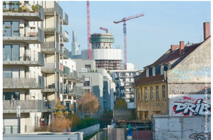
Blick zur Baustelle des Wohnhochhaus „GRAND Tower“
